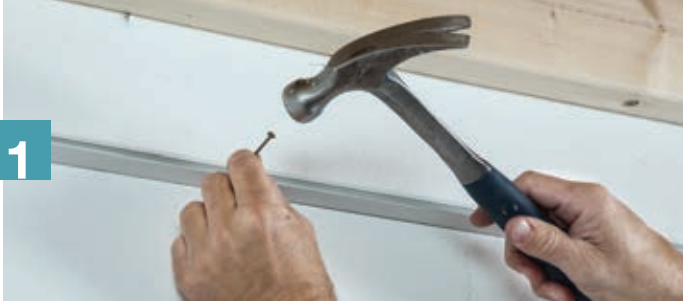
Installation de la moulure murale
