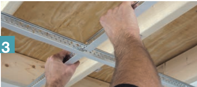
Installez les tés croisés
