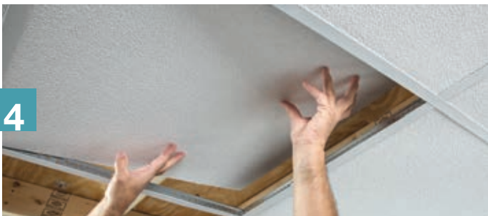
Installez les panneaux de plafond
