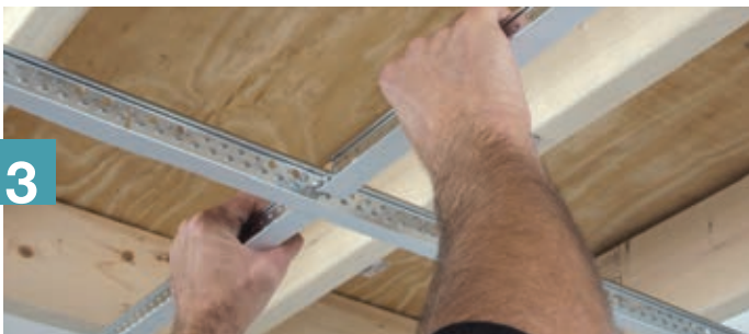
Installez les tés croisés
