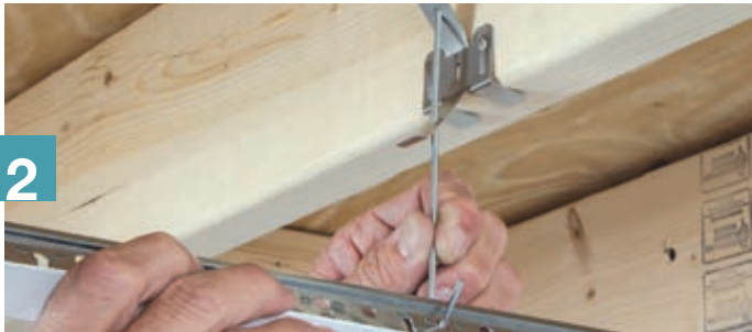
Suspendez les tés principaux au moyen de fils de suspension ou de la NOUVELLE quincaillerie QuickHang MC* (illustré ci-dessus : crochets et supports QuickHang)
