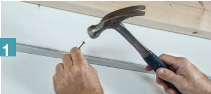
Installation de la moulure murale
