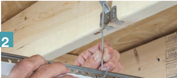
2 Suspendez les tés principaux au moyen de fils de suspension ou de la NOUVELLE quincaillerie QuickHang MC* (illustré ci-dessus : crochets et supports QuickHang)
