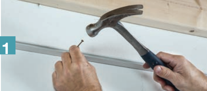
1 Installation de la moulure murale
