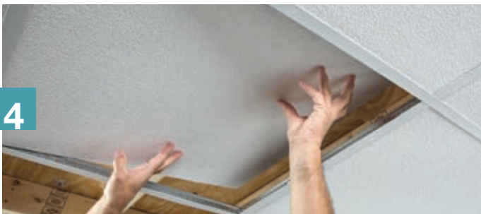
4 Installez les panneaux de plafond
