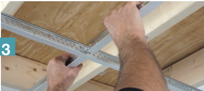
3 Installez les tés croisés
